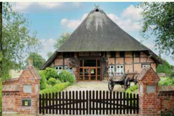
Rauchhaus Möllin - Außenstelle des Museums & Restaurant (27)
